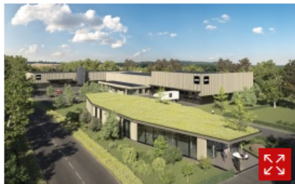
So wird das Ensemble nach Fertigstellung und Anwachsen der umfassenden Begrünung aussehen. © Kapo Fenster und Türen
